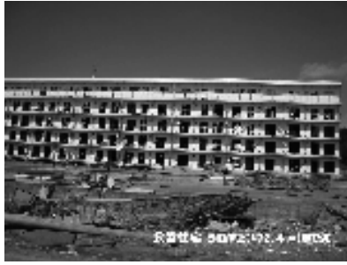
津波の被害 no.2
